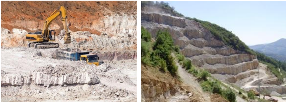
Slika 4. Površinski kop krečnjaka [29, 30]
